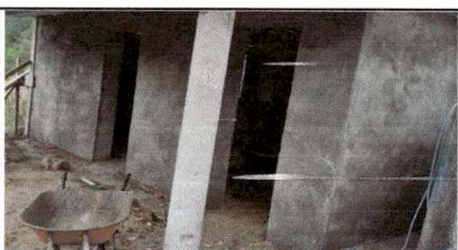
Foto 10: Realización de repello en muro.
