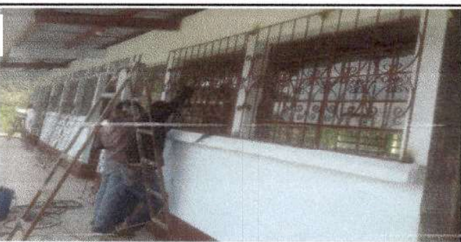
Foto 5: Realización de instalación de balcones de hierro en ventana.
