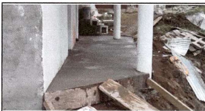
Foto 4: Realización de sustitución de piso de torta de concreto 10cm de grosor.
