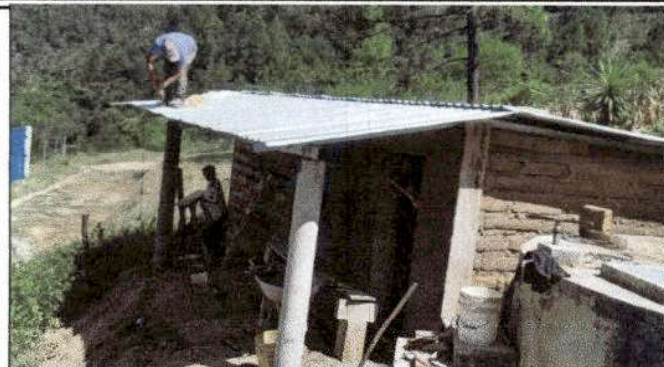
Foto1: Realización de sustitución de lámina, por lámina troquelada aluzinc calibre 26.
