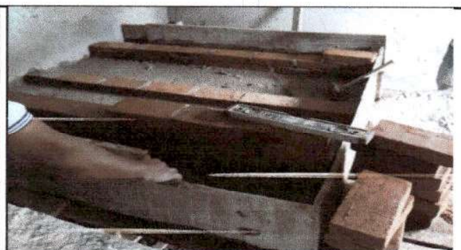
Foto 9: Realización de sustitución de estufa rural (completa) incluye chimena y plancha de metal.
