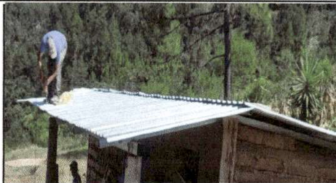
Foto 2: Realización de sustitución de elementos de fijación.
