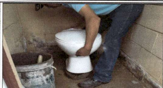
Foto 8: Realización de sustitución de inodoro
