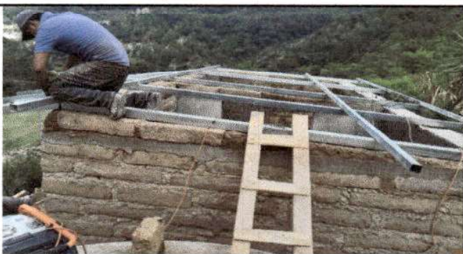
Foto 3: Realización de sustitución de estructura de soporte de madera por metal.
